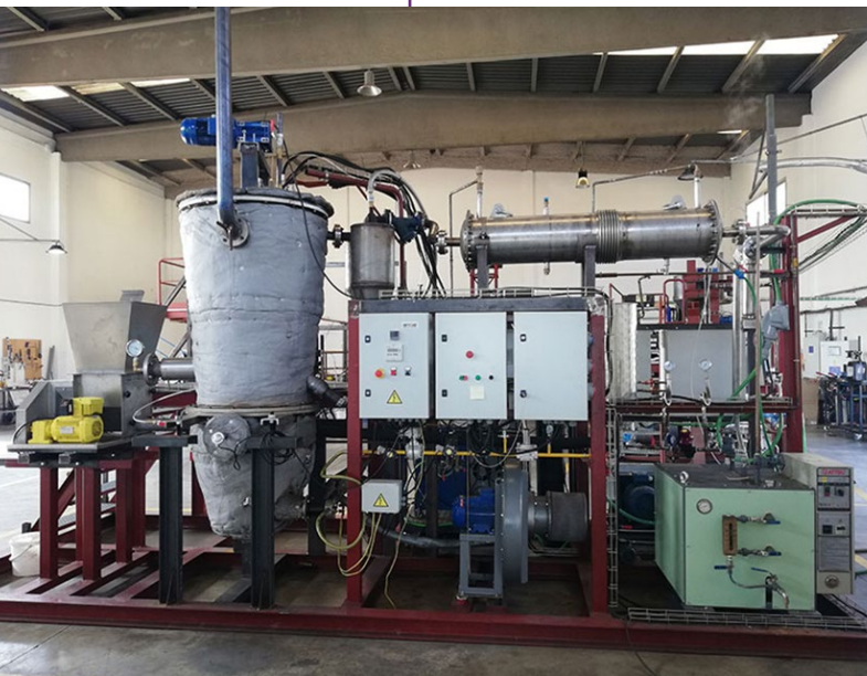
Unidad de gasificación
